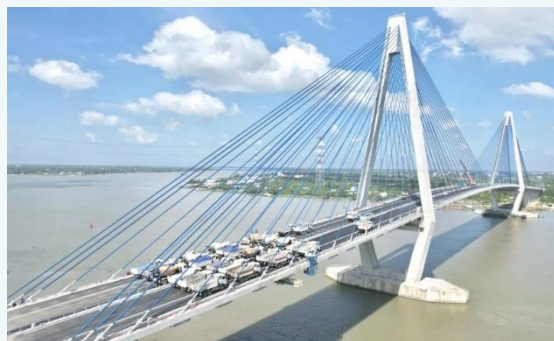
Cầu Mỹ Thuận 2 (Tiền Giang) Đã hoàn thành: 2023
