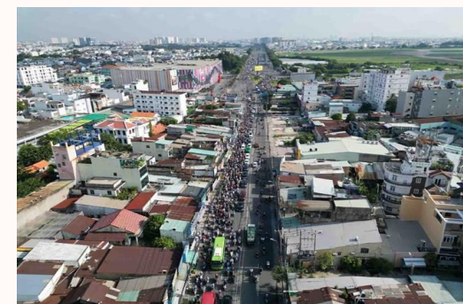
Mở rộng đường Trường Chinh Dự kiến khởi công: 2024-2028
